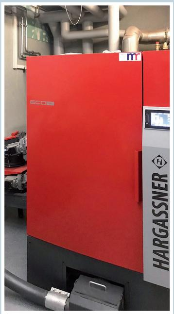
**Das Heizwerk Neuöd** hat 250 kW Anschlussleistung.
